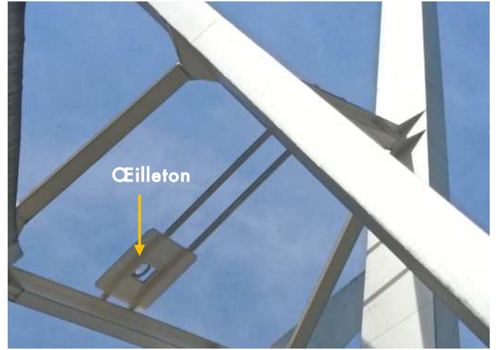
L'œilleton au sommet de la structure
