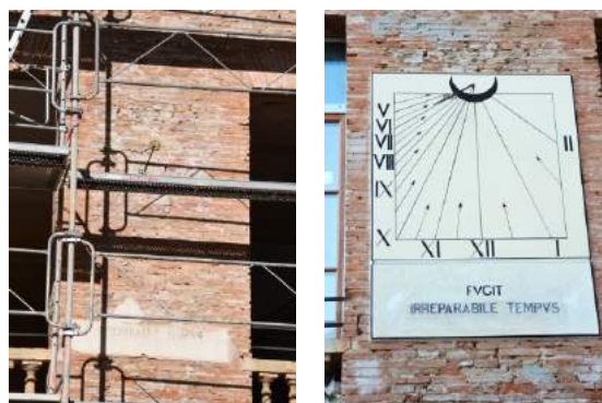
Après le passage des maçons seule reste la devise, qui sera déposée et intégrée dans la nouvelle table
